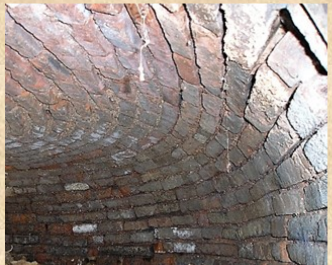
Le plafond en brique du four à pain
