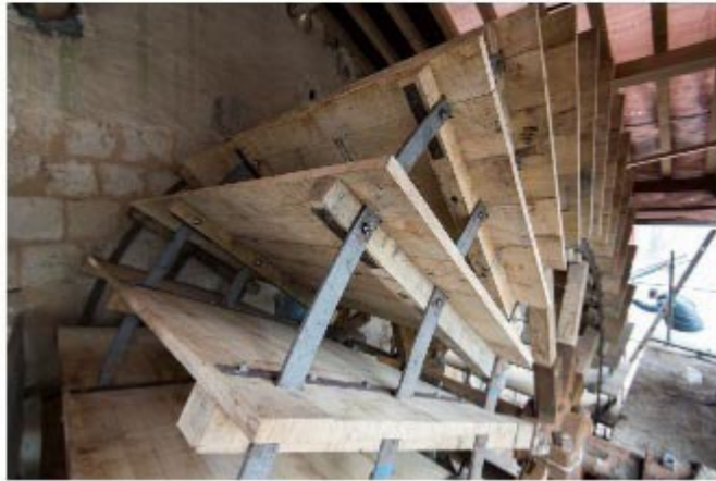
La nouvelle roue du moulin Bardin est posée © JB Dos Ramos
